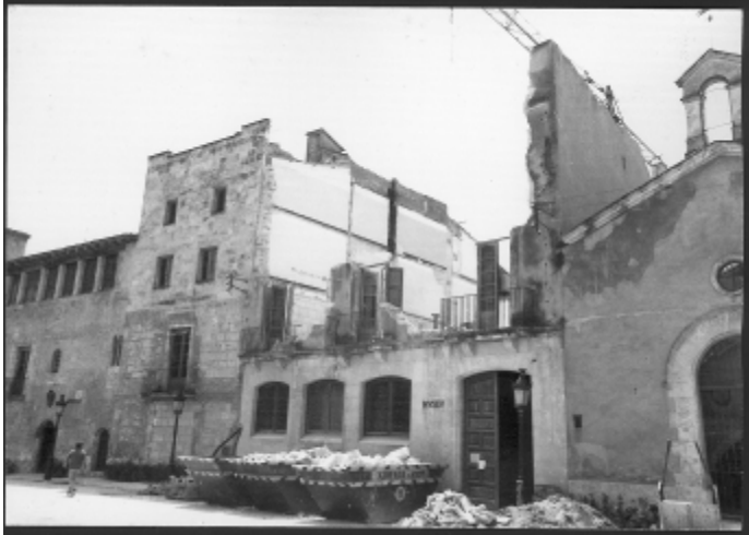
Obres d'enderroc de Cal Pa i Figues
